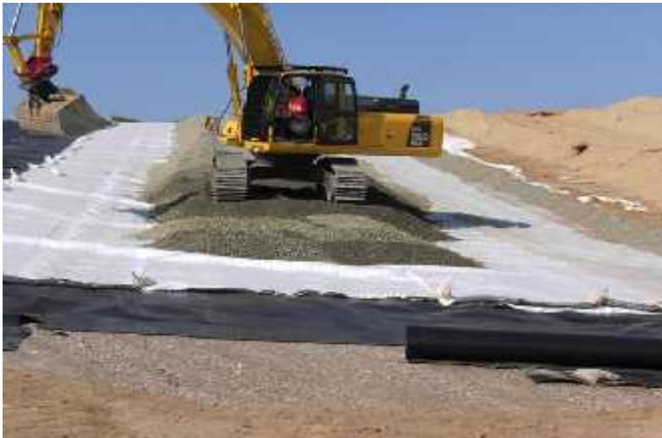
Bild 7.1.3: Darstellung des Querschnittes der Oberflächenabdichtung im Probefeld
